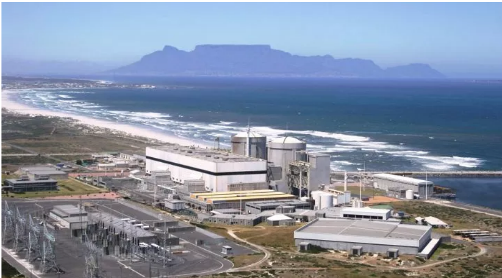
La centrale nucléaire de Koeberg, située près de la ville du Cap. © Eskom
