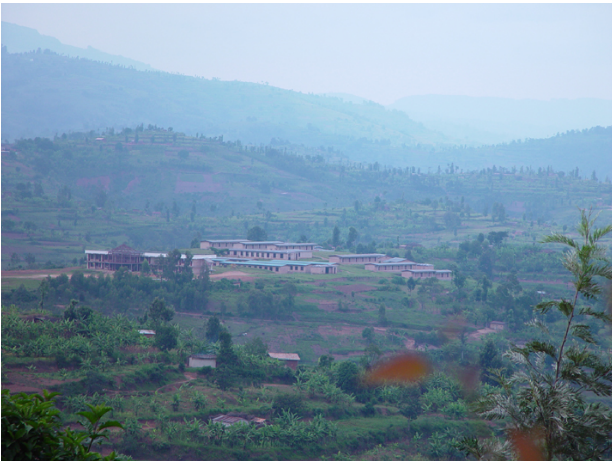
FIGURE 29.3 – Vue générale de l'école de Murambi (Gikongoro) après le génocide. On distingue le musée en construction devant le bâtiment à 2 étages. Source : DG
