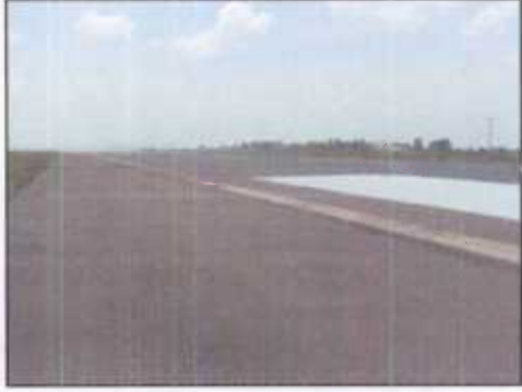
VUE DE LA PISTE VERS L'ANCIENNE TOUR DE CONTROLE
