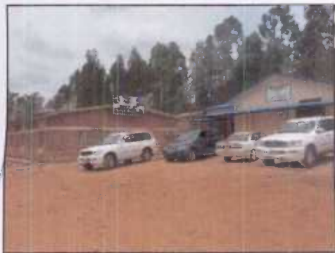
MAISON COMMUNALE DE KANOMBE QUARTIER NYARANGUNGA
