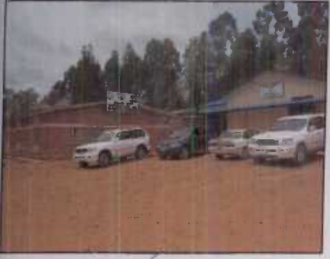
MAISON COMMUNALE DE KANOMBE QUARTIER NYARANGUNGA
